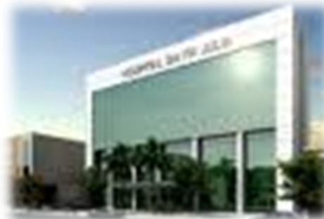
Projetos e Instalações – Hospital Santa Julia
