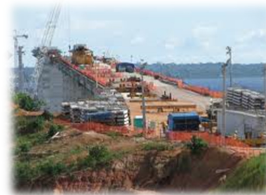
Projetos e Instalações – Canteiro de obras Ponte sobre o Rio Negro
